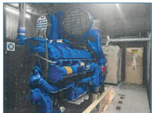
ภาพถ่ายที่ 2.2-12 เครื่องกำเนิดไฟฟ้าสำรอง
